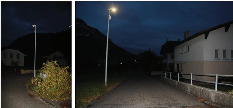
Bei uns in den Quartierstrassen im Einsatz : Mini Quadralux 2 2928lm, 29W, 4000K und Bewegungssensoren Com Light Eagle Eye je 1 Sensor mit GPRS ,RF-Modul , Dali der Firma Elektron ausgestattet.
